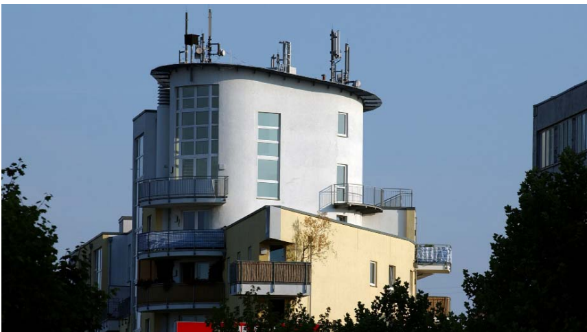
Bevorzugt werden Antennen auf hohen Gebäuden installiert. Die Stationen erzeugen Mikrowellen, auf denen das Mobilfunknetz basiert.
